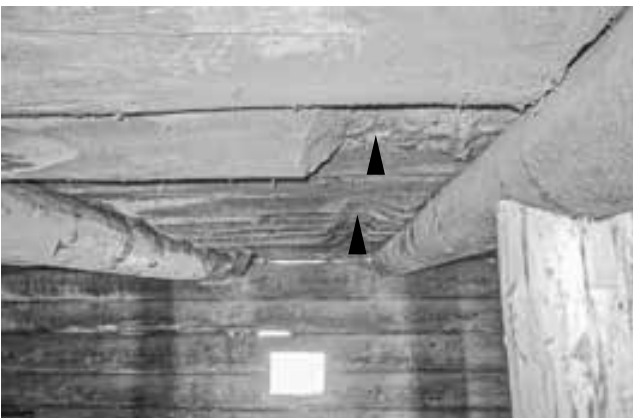
Lagerung der Stalldecke auf zwei Unterzügen 1729i
