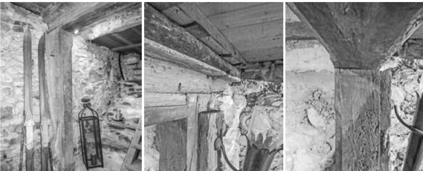
Kellereingangsportal – Details li. westlicher Türstock mit originären Torkloben – Türanschlag außenwandseits, Falz für das Torblatt 6/5 cm, Tür stumpf einschlagend; mi. Portalsturz mit unterseits nachträglich abgearbeiteter Nut für die einlaufenden, originalen (abgegangenen) in Nord-Südrichtung gespannten Deckenbohlen; re. östlicher ebenso gefalzter Türstock mit breiter, mit Dreiecksfläche anlaufender Kantenfasung
