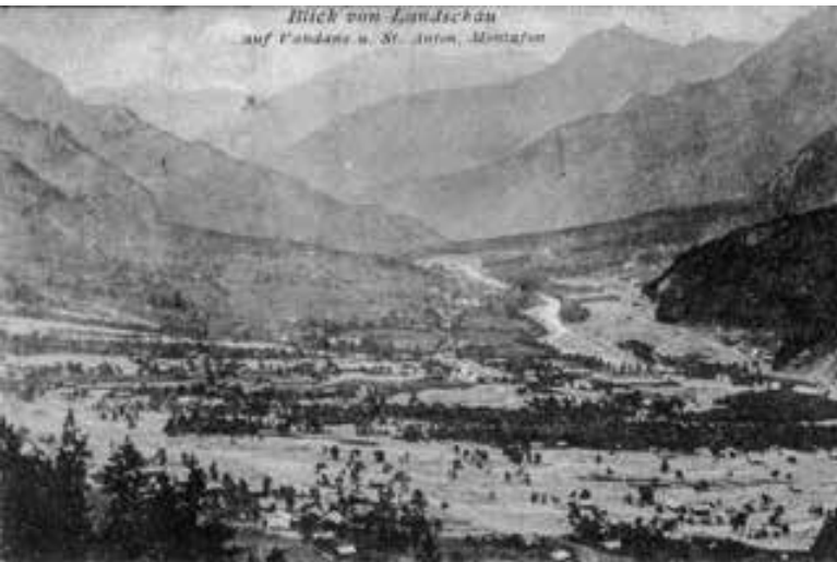
Blick von Latschau auf das verwüstete Vandans und St. Anton,
