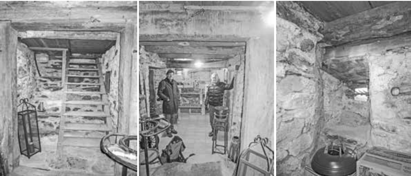
Kellergeschoß Bp. .89, südlicher Gebäudeabschnitt li. Kellereingangssituation mit später eingestellter Holztreppe mit in die Wangen eingeschobenen Trittstufen; mi. Blick in den sekundär vom Kellerraum ausgeteilten Gang; re. an die Außenwand angestellte Binnentrennwand die auf ein zweifach getrichtertes längsrechteckig liegendes Kellerfenster mit originalem gotischen Wolfseisen zuläuft; im Anschlussbereich Korrektur der Mauerflucht in Richtung der östlichen Gewändekante
