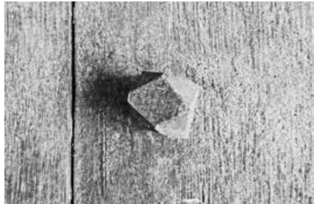
li. umbauzeitlicher Stalltürsturzdrehung bez. „Ludwig“ möglicherweise die Initiale „L“ der Inschrift; re. Detail an der Tür des talseitigen Kleinviehstalls; Nagelkopf im Gegensatz zu denjenigen an der Großviehstalltür mit Eckenfasung
