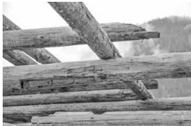
li. Dreschenn, Blick vom Fanill aus gegen die Heuscheune, re. ehemaliger Scheunentorsturz 1576dh, Tor zweiflügelig gegenläufig öffnend
