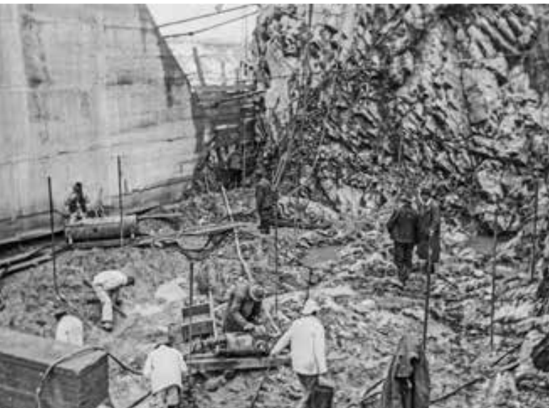
Baustelle in der Silvretta, 1942
