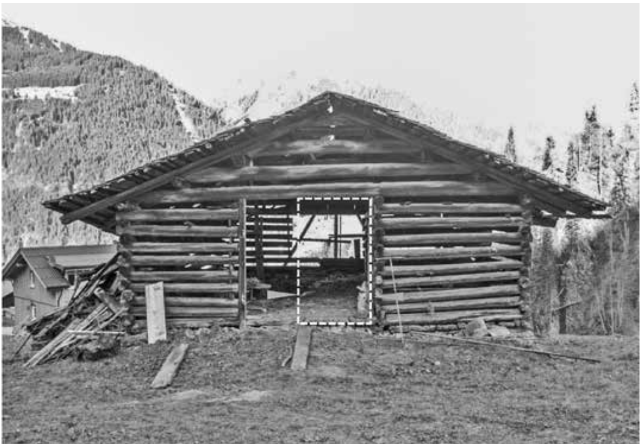
bergseitige Erschließungssituation des Scheunengeschoßes, ursprüngliche Torweite ▶
