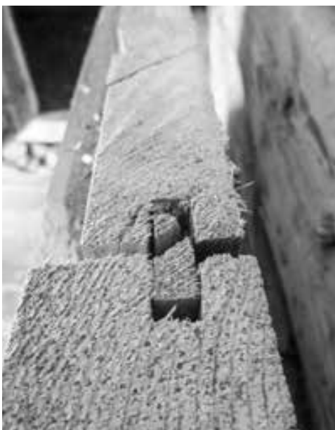
Torblattdetails – Großviehstall
