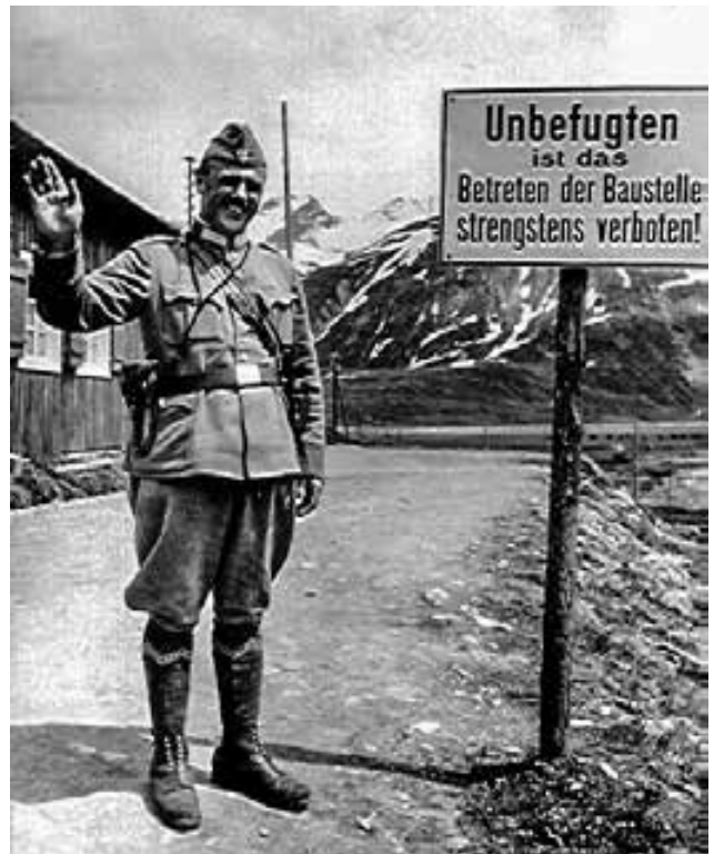
Wachsoldat auf der Baustelle in der Silvretta
