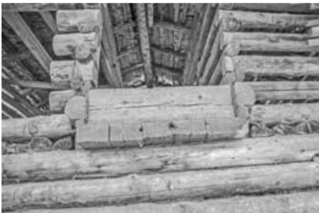
li. Dreschenn, Blick vom Fanill aus gegen die Heuscheune, re. ehemaliger Scheunentorsturz 1576dh, Tor zweiflügelig gegenläufig öffnend
