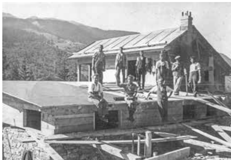
Martin Barbisch (vorne links) auf einer Baustelle im Prättigau
