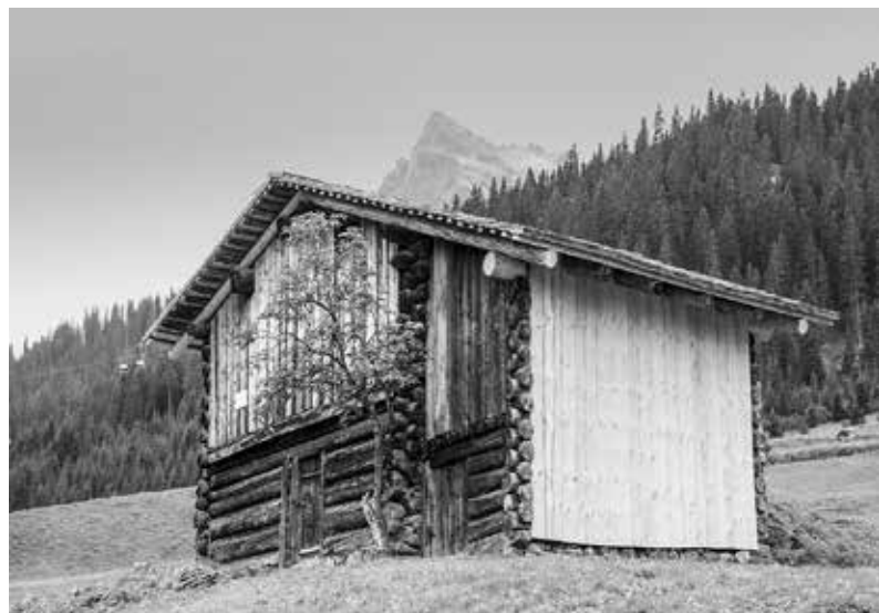
Widum Stall renoviert im Jahr 2011, Gründungsbau aus dem Jahr 1487, erweitert 1757
