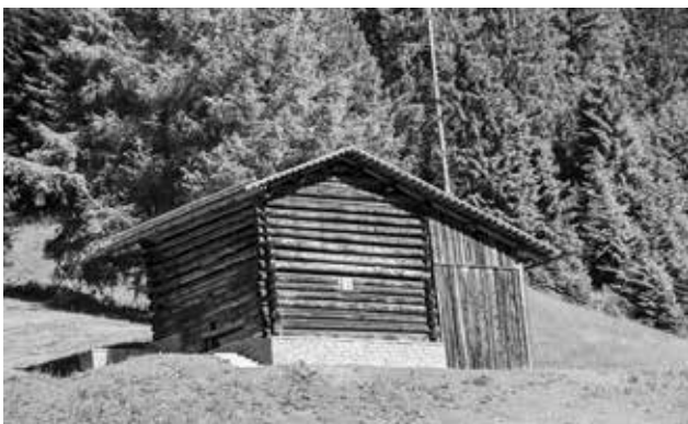
Neubau mit alter Hülle, Dezember 2015
