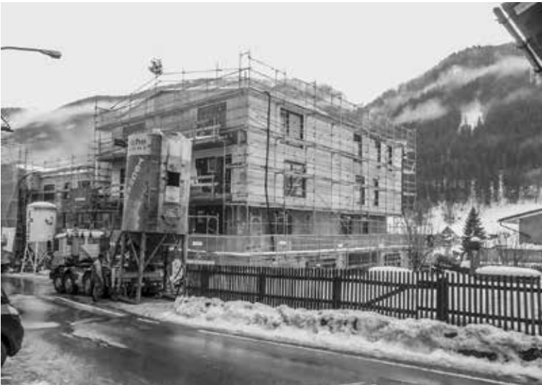
Foto: Marlies Kuster, Neubau auf dem Grundstück der „Alten Krone“, direkt neben dem Alpin- u. Tourismusmuseum Gaschurn
