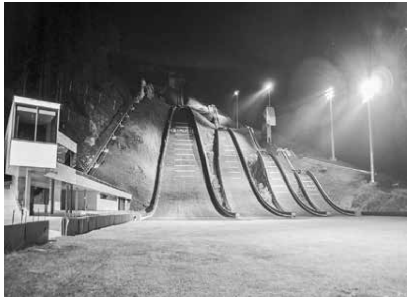
Abb. 8.: Das fertiggestellte Schanzenzentrum mit Flutlichtanlage (Abb. Schanzenzentrum Montafon Nordic).
