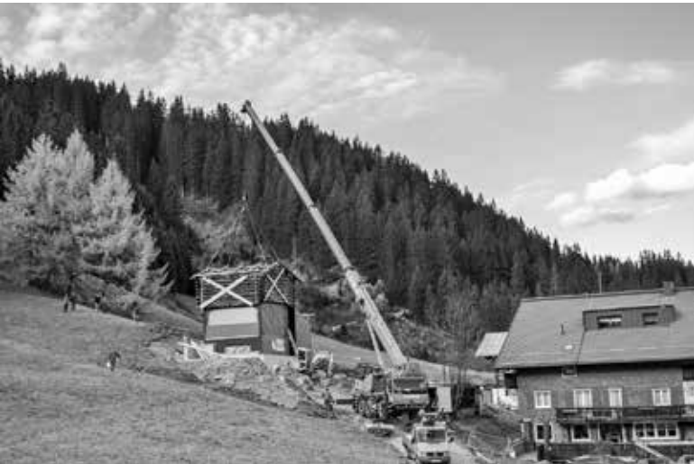
Hier wird die alte Hülle über das neue Haus gestülpt.
