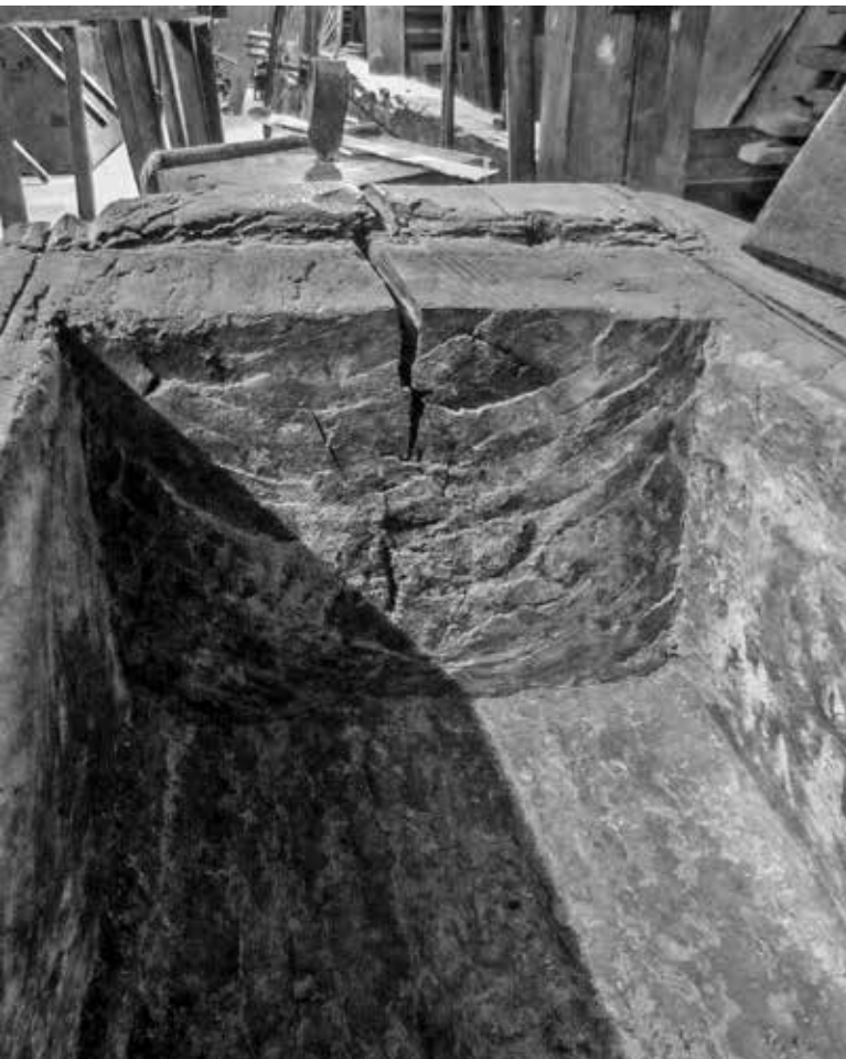
Stirnanseite der Aushöhlung mit Bearbeitungsspuren eines Dechseis (Schnittlinien verlaufen quer zur Hiebrichtung)
