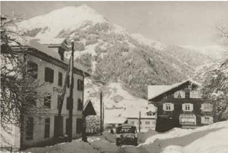
Altes Schulhaus in St. Gallenkirch mit der Arrestzelle im Keller (links)
