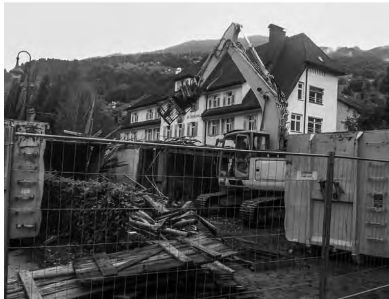
Abbruch des Stalles beim Josefsheim
