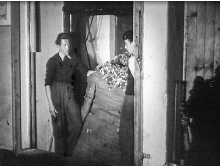
Transportaufzug vom Keller in die oberen Stockwerke
